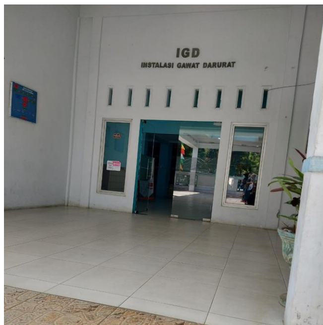
Gambar 2. Instalasi Gawat Darurat (IGD) RSUD Aceh Tamiang
