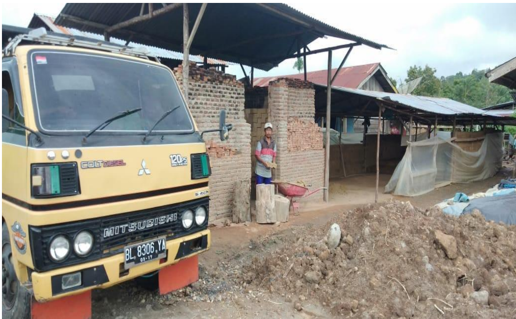
Gambar 8. Pembongkaran Batu Bata
