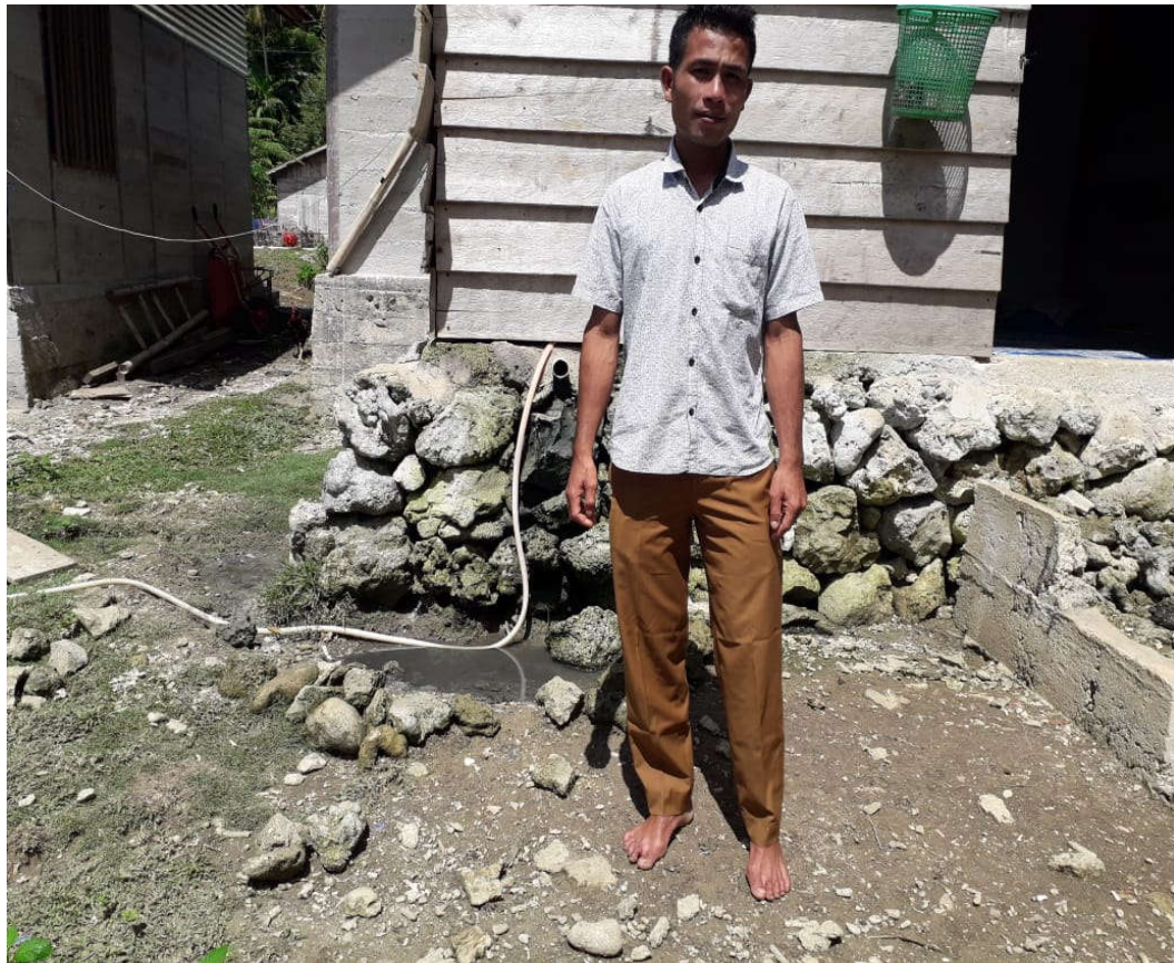
Gambar 8. Saluran pembuangan air limbah dibelakang rumah Tn. E
