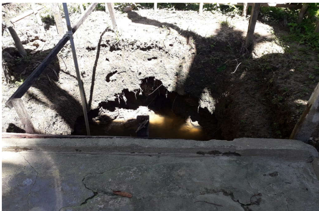
Gambar 2. Sumur gali yang bagian dalam dan bibir sumur tidak disemen hanya sebagian lantai saja
