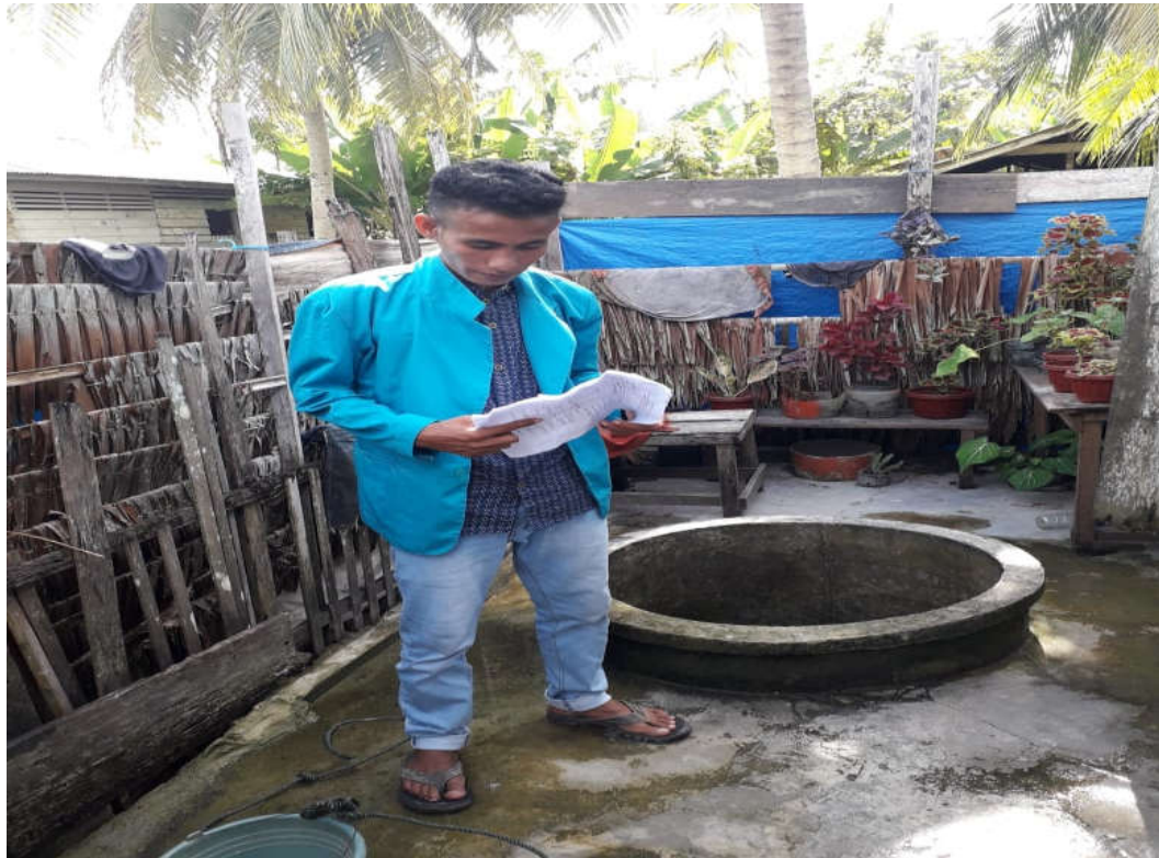
Gambar 3. Sumur gali yang disemen tetapi dinding bibir sumur terlalu rendah
