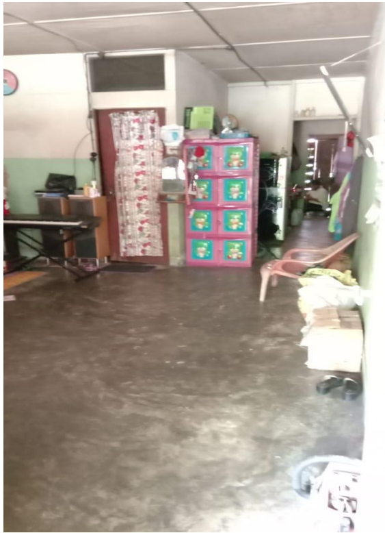
Gambar 5 Kondisi Rumah Penduduk
