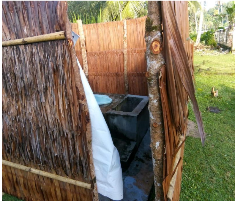
Gambar 23. Kondisi Jamban Masyarakat di Desa Leubang Hulu
