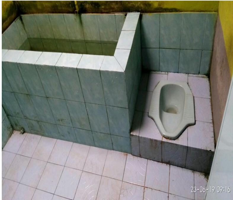
Gambar 31. Kondisi Jamban Masyarakat di Desa Leubang Hulu
