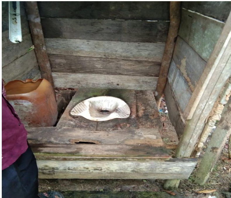
Gambar 26. Kondisi Jamban Masyarakat di Desa Leubang Hulu
