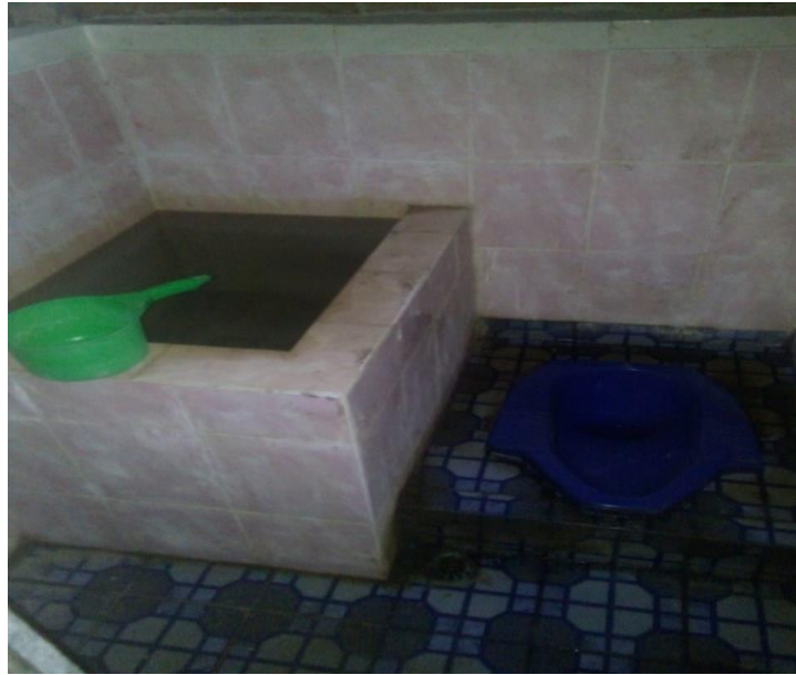
Gambar 9. Kondisi Jamban Keluarga
